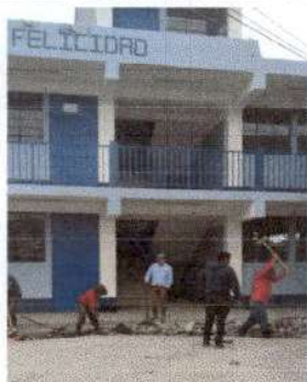
Foto 1: Reparación de piso de torta de concreto.
