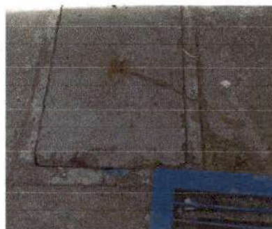
Foto 4: Sustracción de caja de contador.
